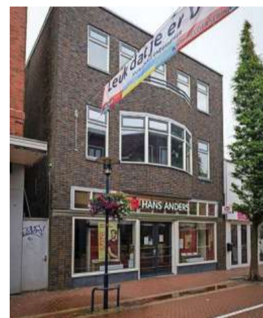
Het pand waar nu Hans Anders is gevestigd, na de renovatie.
