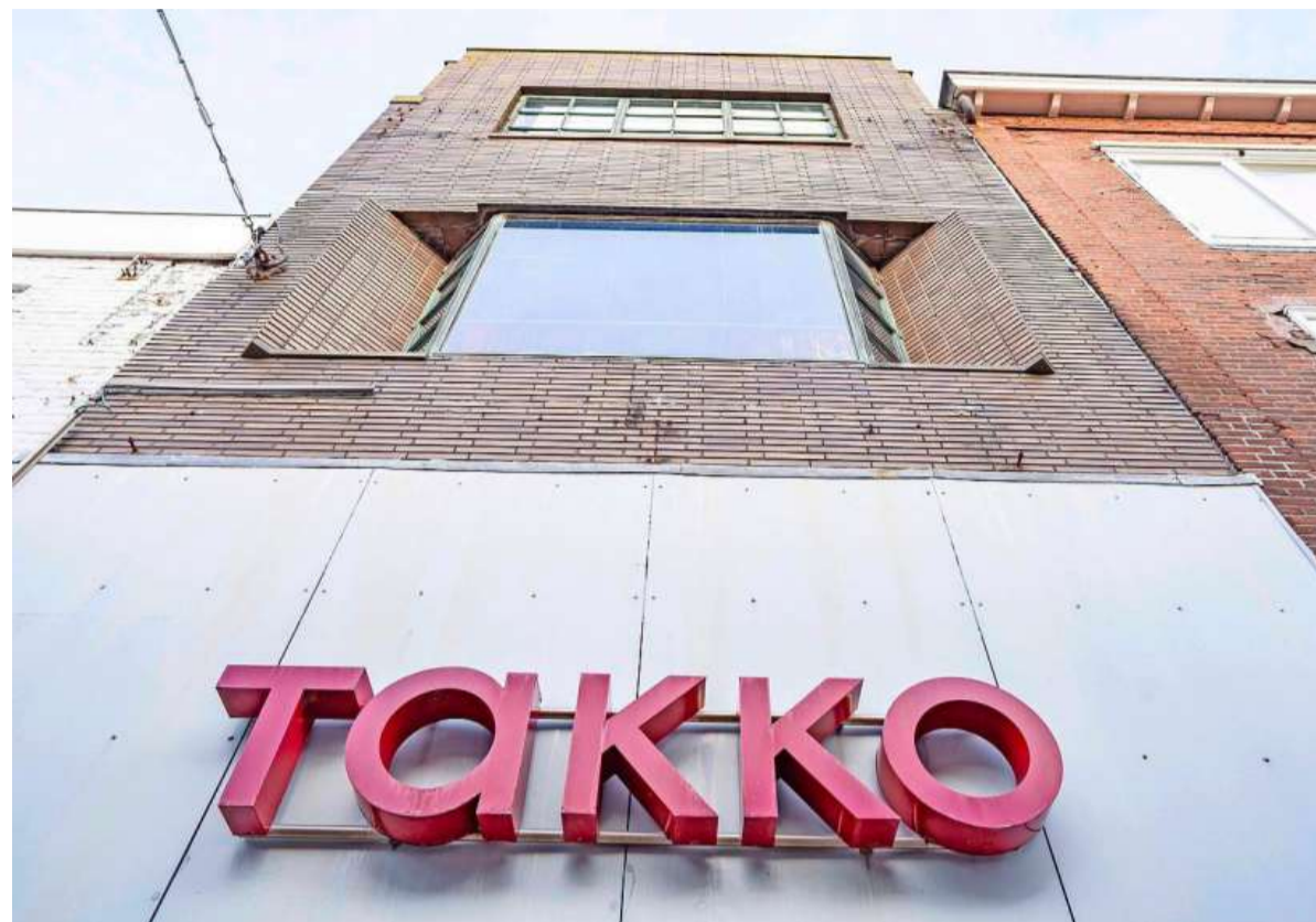
De bovenkant van dit winkelpand heeft een uitgesproken jarendertigstijl.
